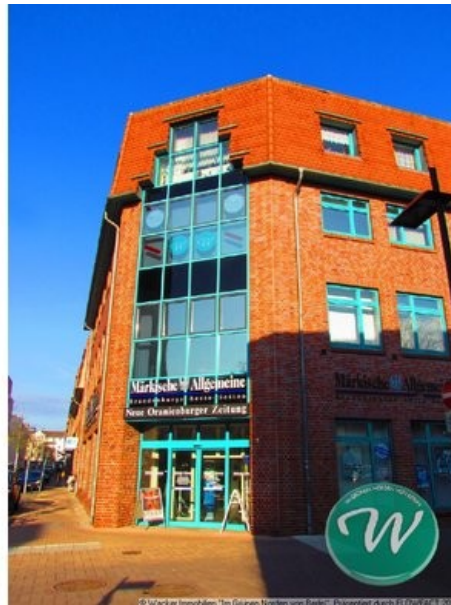
Wohn- und Geschäftsgebäude
