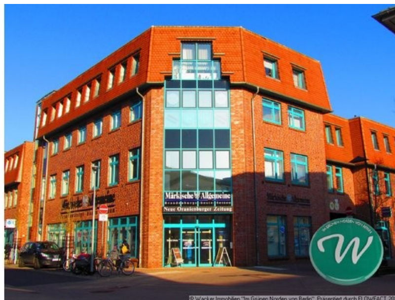
Wohn- und Geschäftshaus Mittelstraße
