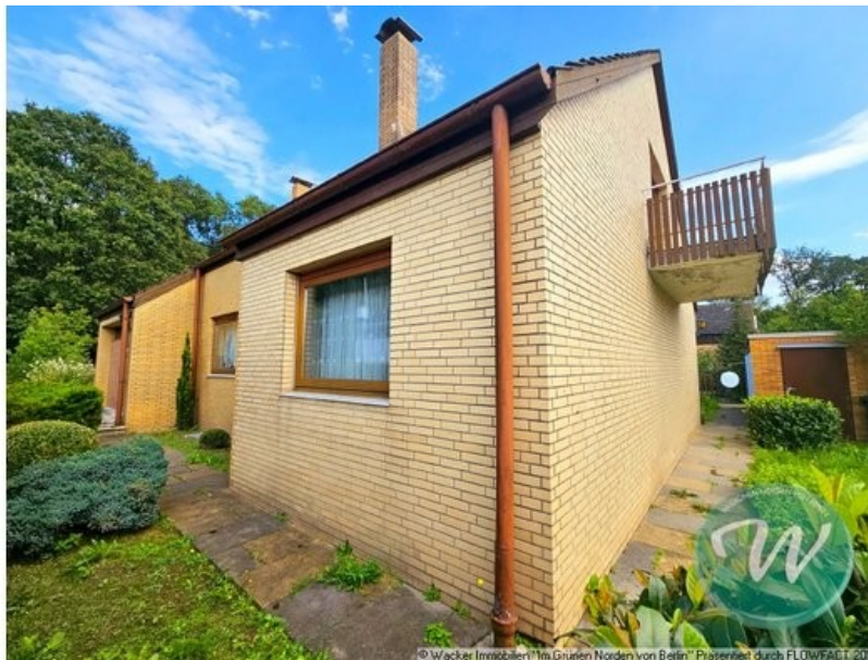
Nordwestseite mit Südwestgiebel
